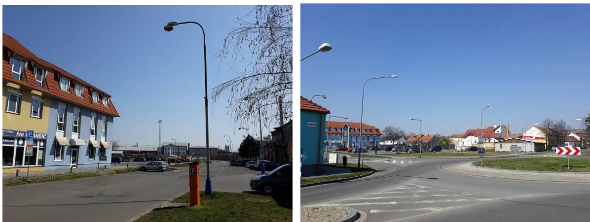
Pohled od severozápadu z ulice Slovácké a od jihu z ulice Stromořadní
