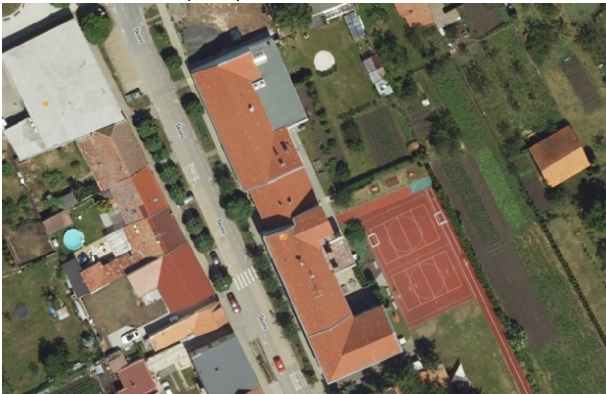
Obrázek č. 1.2.8: Pohled na střechu objektu – ZŠ Jana Noháče
