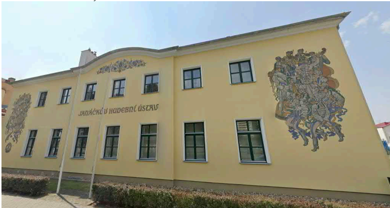
Obr. 1.4.7: Pohled na budovy
